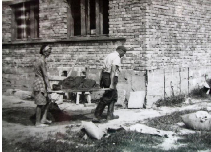
Fent: Dunafalva nagyobb mértékű kiépülése idején a gépesítés csak részben működött, az építkezések zömmel kézzel zajlottak. Bleier Ferencék házának építése a Tanácsház (ma Tavasz) utca 11. sz. alatt. A saroglyával a leendő háziak: Bleierné Király Katalin (sz. 1941.) és Bleier Ferenc. (Sz. 1935.) (1969. Bleierné Király Katalin gyűjteményéből.)
